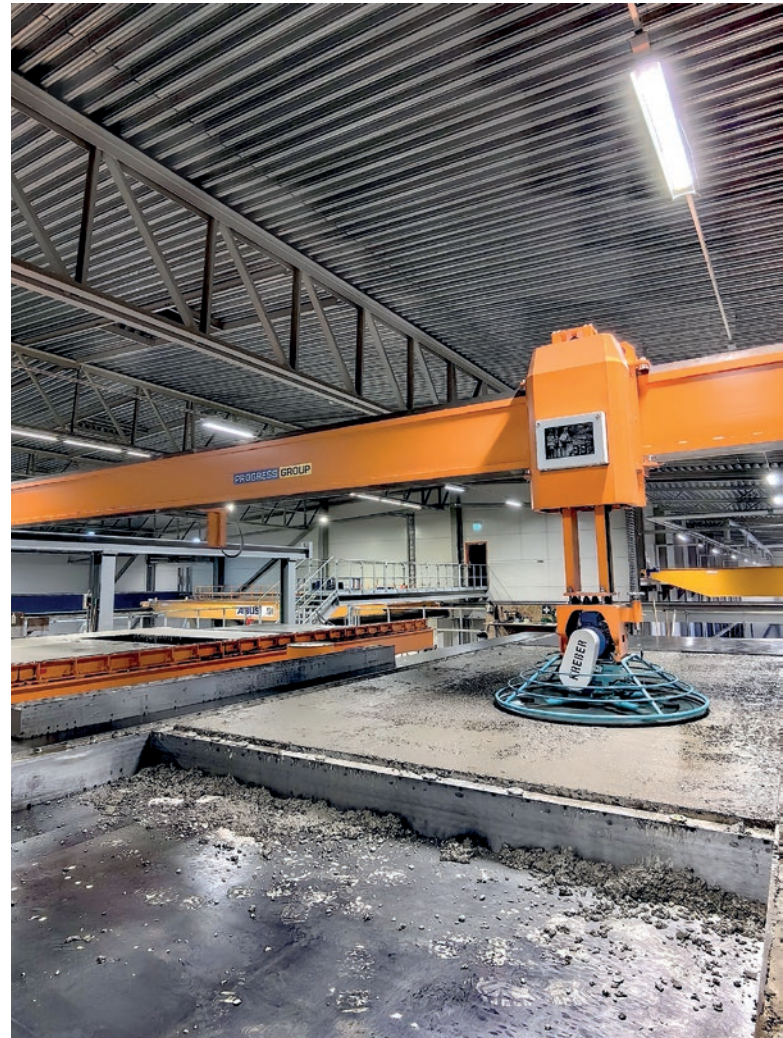
Aby uzyskać gładką powierzchnię elementów betonowych, świeżo ułożona i zagęszczona mieszanka betonowa musi zostać wyrównana zacieraczką.
