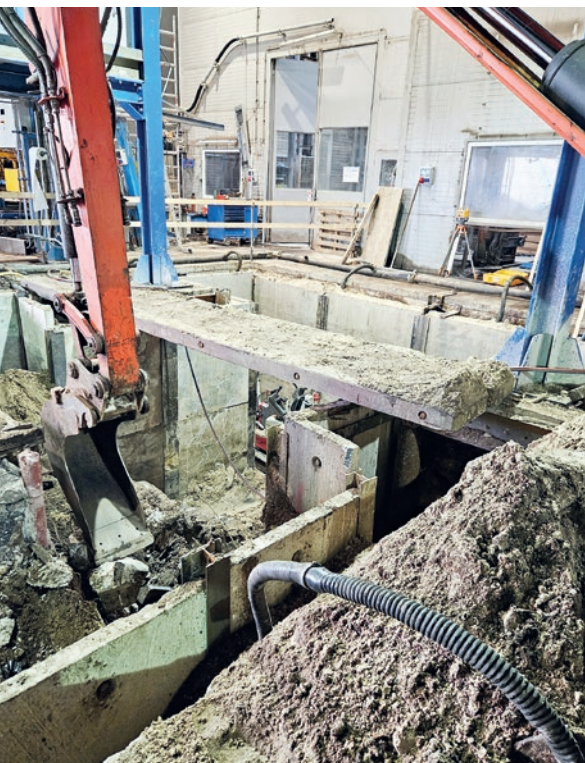
Przygotowywanie fundamentów (Hardenberg).
