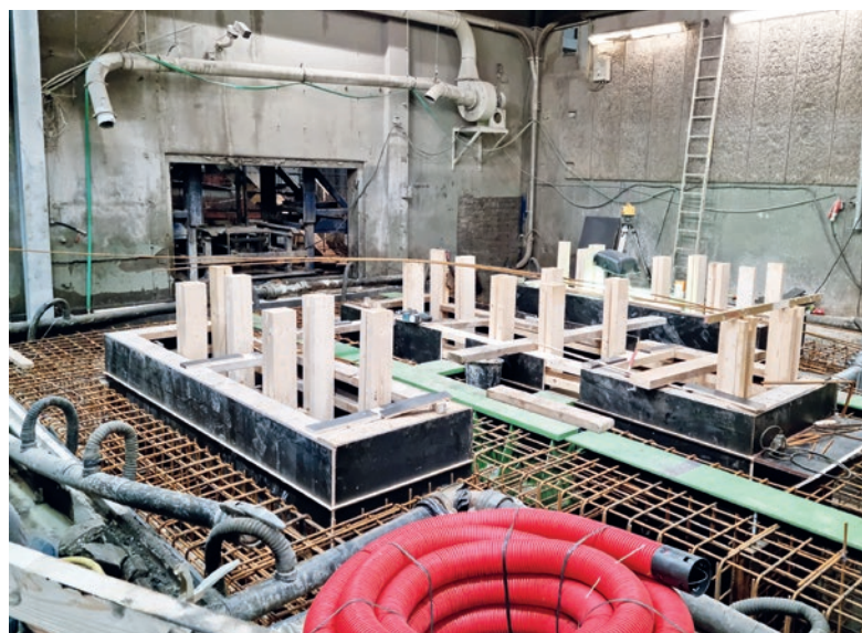
Przygotowywanie fundamentu (Hengelo).
