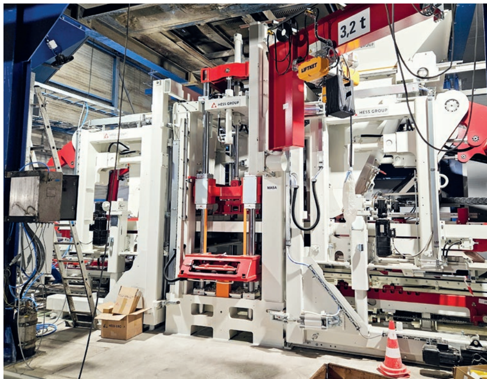
Montaż wibroprasy RH 1500-4 MVA (Hardenberg).
