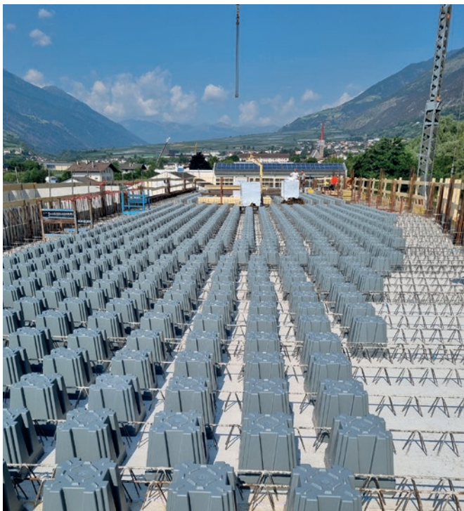
Płyta Green Code Eco Slab® jest uzupełniana na budowie o GC top, tj. górną połowę wkładki formującej, która jest dostępna w różnych wersjach dla różnych grubości stropu.
