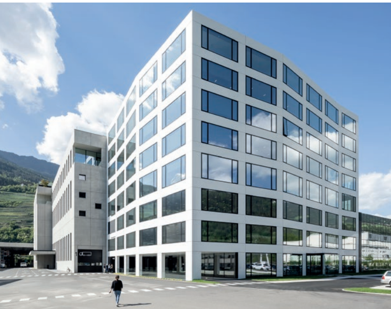
W firmowym zakładzie, zaledwie kilka metrów od nowej siedziby Progress Group, odbywa się produkcja prefabrykatów betonowych.
