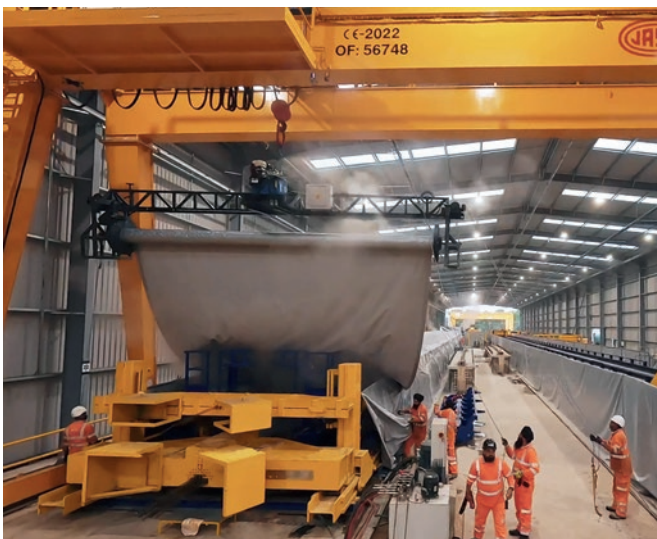
Napędzana silnikiem rolka plandeki jest przeciągana nad formą za pomocą suwnicy, co powoduje równomierne rozwinięcie plandeki.
