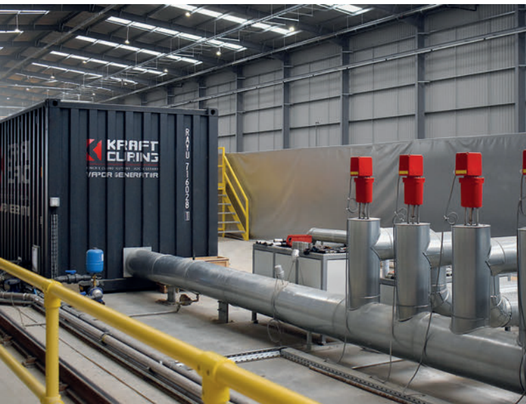
L'unità generatrice di vapore containerizzata con 4 valvole per il vapore automatiche
