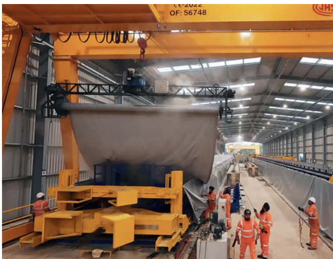
Il sistema di rotolamento motorizzato trasla su un carro ponte lungo la cassaforma facendo scorrere uniformemente il telone
