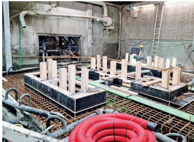
Preparazione delle fondazioni (Hengelo)
