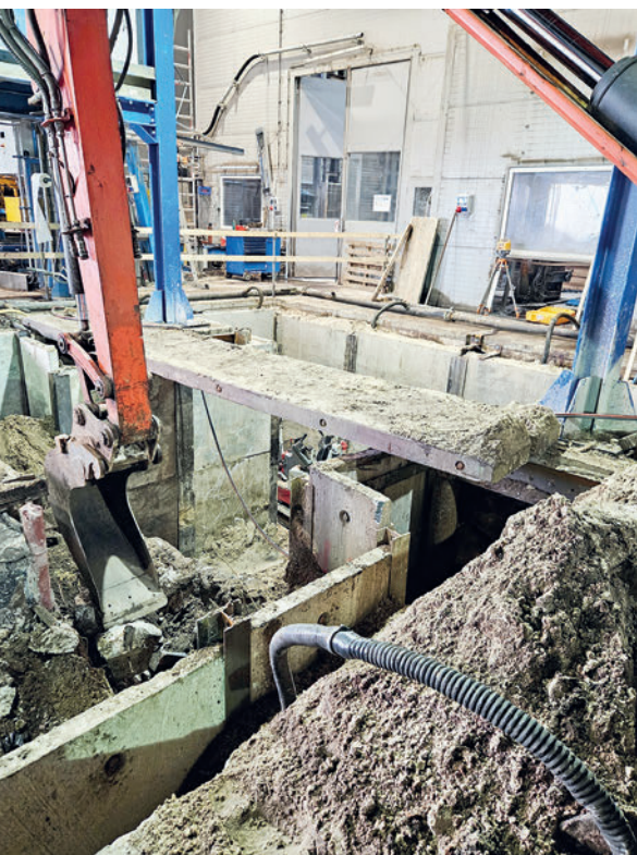
Preparazione delle fondazioni (Hardenberg)
