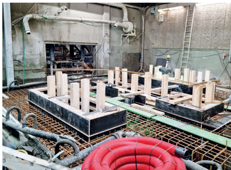
Préparation des fondations (Hengelo)
