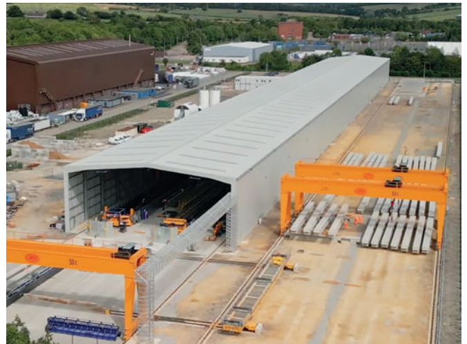
L'usine de la coentreprise FTB à Melton Mowbray a une longueur impressionnante de 365 m.
