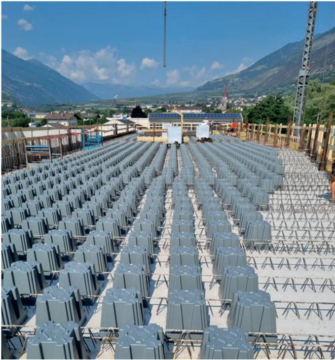
La losa Green Code Eco Slab® se completa en obra con la GC top, es decir, la mitad superior del cuerpo de entalladura, que está disponible en diferentes variantes para diferentes espesores de losa.
