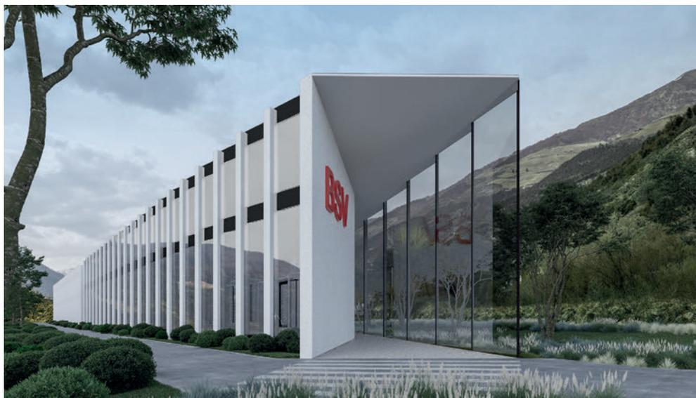
La nueva sede central de BSV es un excelente ejemplo de lo moderna, sostenible y rápida que puede ser la construcción con prefabricados de hormigón.
