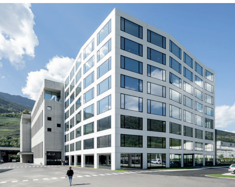
Nur wenige Meter vom neuen Headquarter der Progress Group entfernt wird im eigenen Fertigteilwerk produziert.
