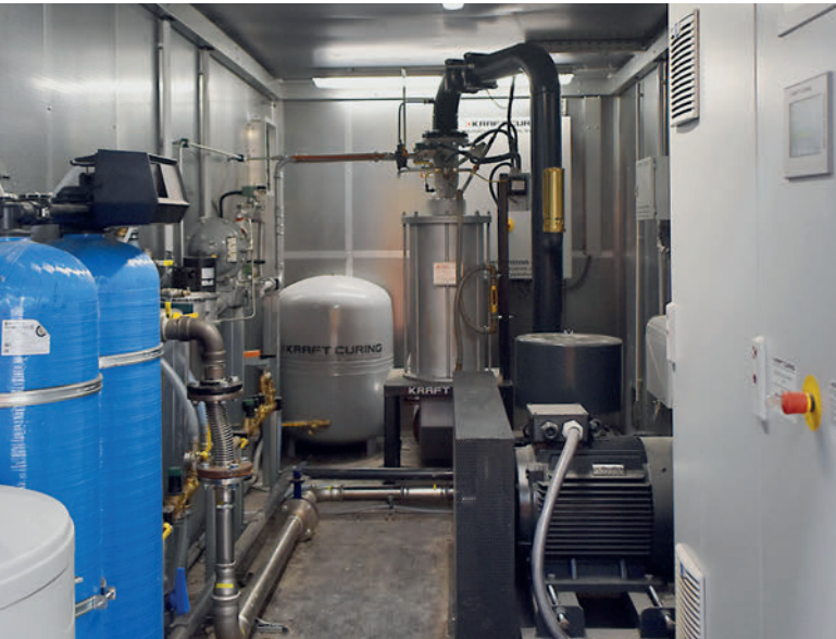
Die voll ausgestattete containerisierte Vapor-Generator-Einheit
