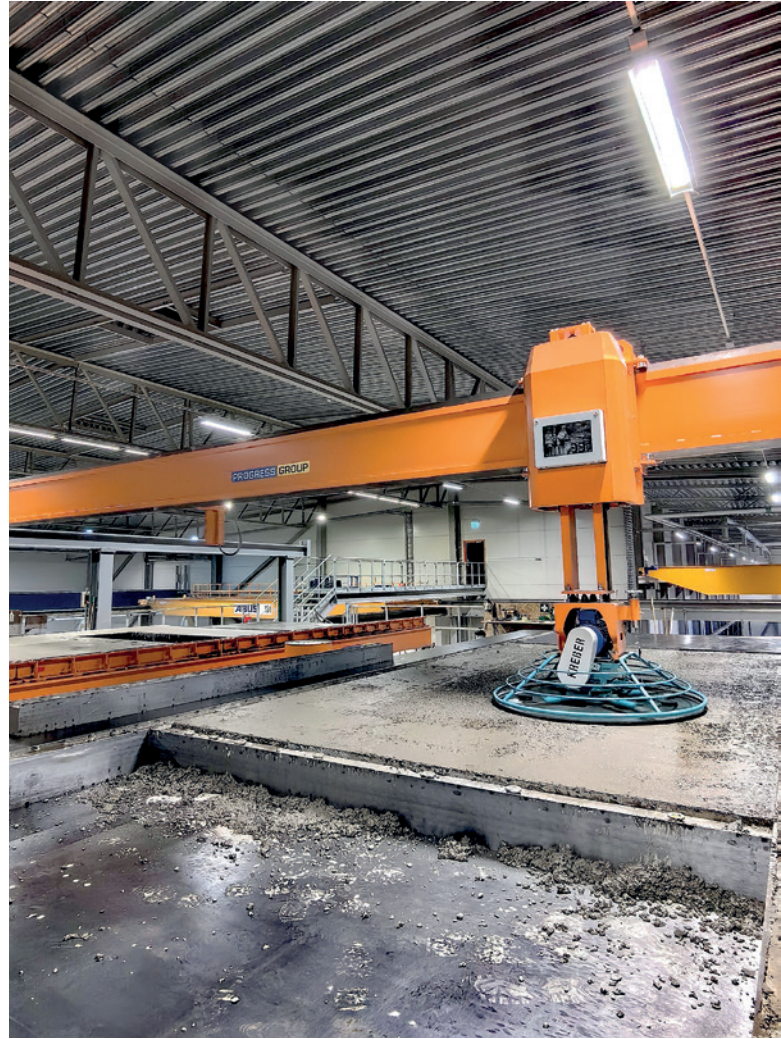
为了获得光滑的混凝土表面，必须使用抹光机刮平刚浇筑和压实的混凝土
