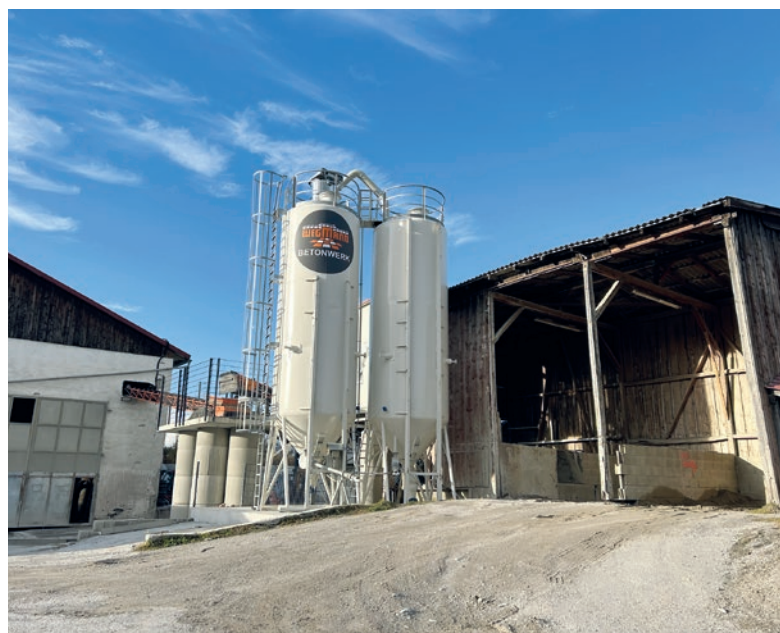
Firma Kniele zamontowała też dwa nowe silosy cementu.
