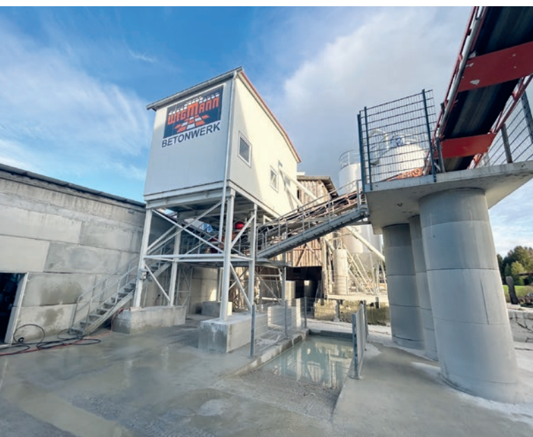
Nowy węzeł betoniarski w zakładzie firmy Wegmann.
