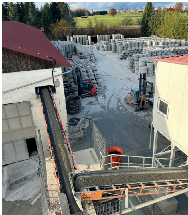
Mieszanka betonowa o konsystencji wilgotnej trafia za pośrednictwem przenośników taśmowych bezpośrednio do obszaru produkcyjnego.
