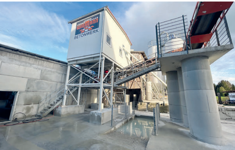
Vista sul nuovo impianto di betonaggio presso Wegmann
