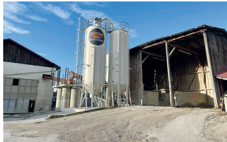
Kniele ha installato anche due nuovi silos per cemento.
