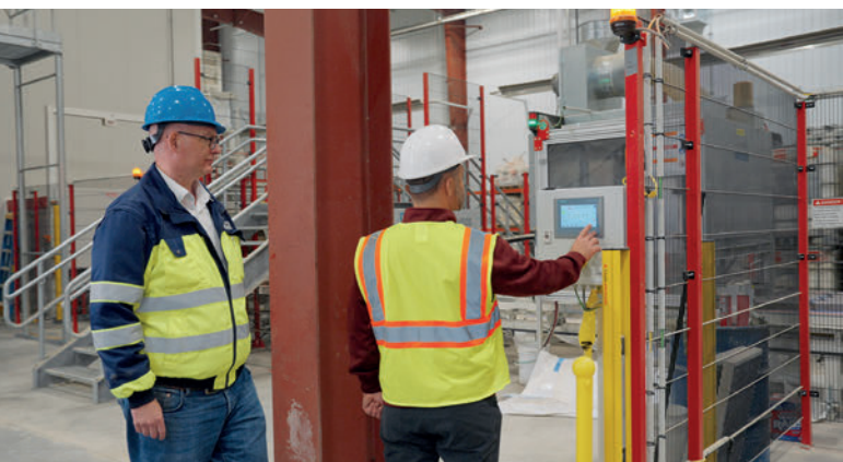
Oliver Rauter, amministratore dell'Hess Group, e Jeff Price, presidente della Rochester Concrete Products, durante la verifica dei controlli di sicurezza del nuovo impianto.
