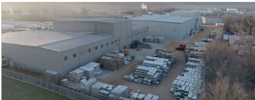
La nouvelle usine de Rochester Concrete Products sur le site d'Interlock Concrete, à Jordan (Minnesota)
