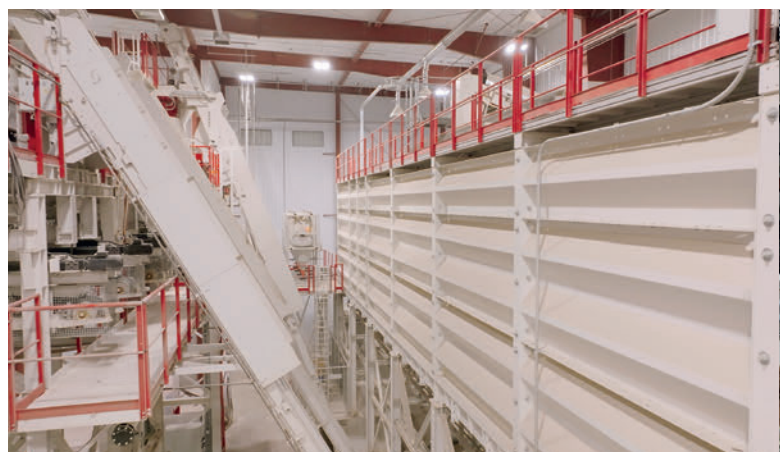
Une aire de stockage intérieure d'une capacité de 660 tonnes permet de maintenir un taux d'humidité constant des matières premières.
