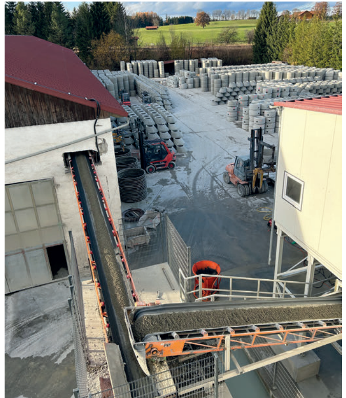
El hormigón ligeramente húmedo llega directamente a la zona de producción a través de cintas transportadoras.
