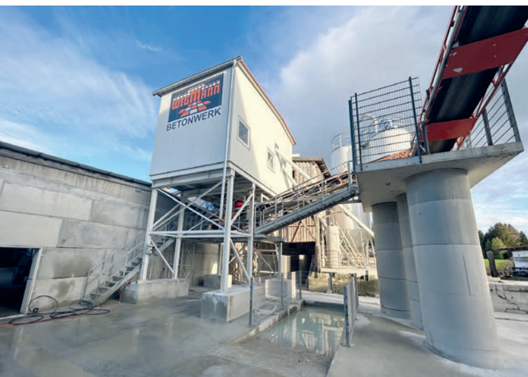
Vista de la nueva instalación mezcladora de hormigón de Wegmann
