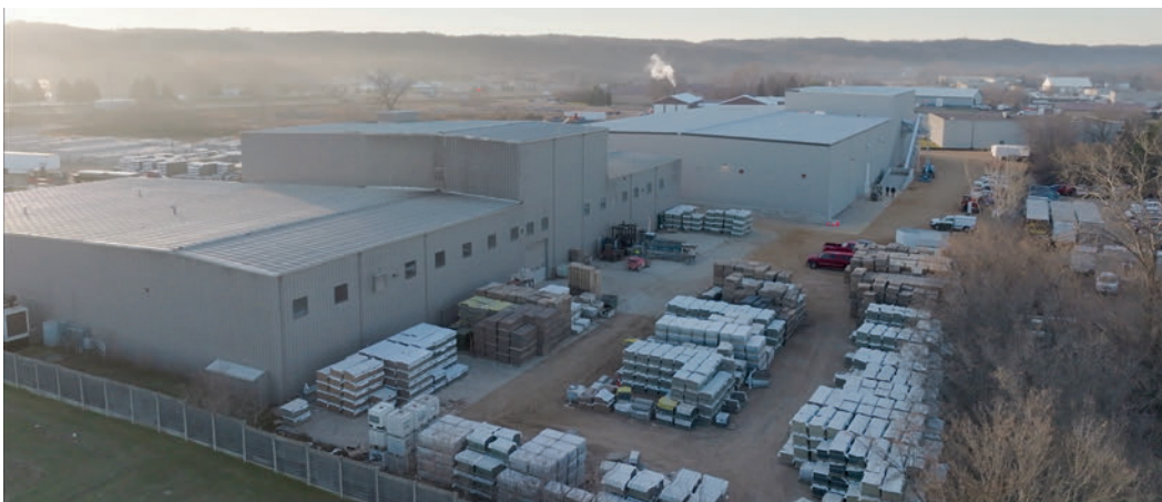
La nueva planta de Rochester Concrete Products en la sede de Interlock Products de Jordan (Minnesota, EE. UU.)
