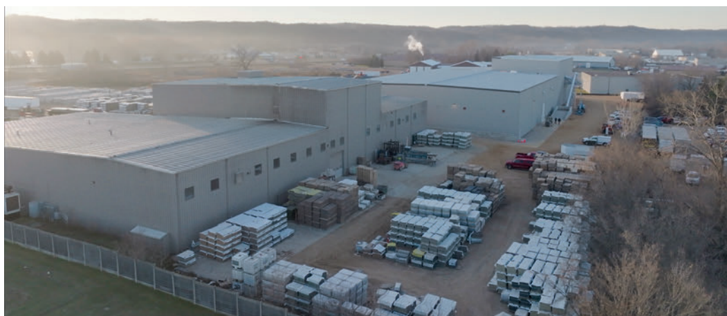
Die neue Anlage von Rochester Concrete Products am Standort von Interlock Products in Jordan, US-Bundesstaat Minnesota
