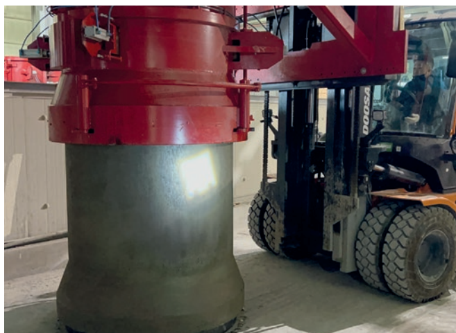
Automatyczne rozformowywanie przy użyciu wózka widłowego.
