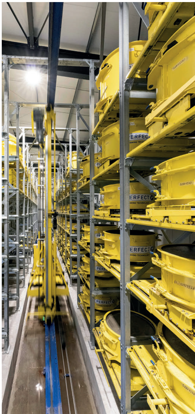
Magazzini a scaffali come aree di indurimento efficienti e poco ingombranti per i prodotti induriti in cassaforma
