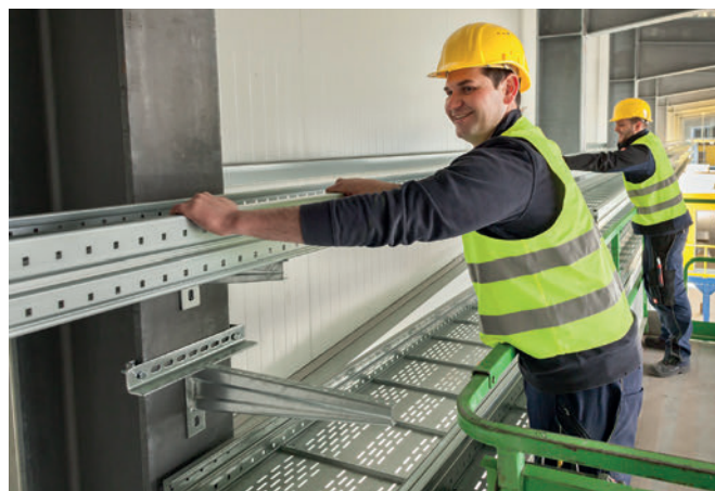
Professionnel et dans les délais : pose des nouveaux câbles
