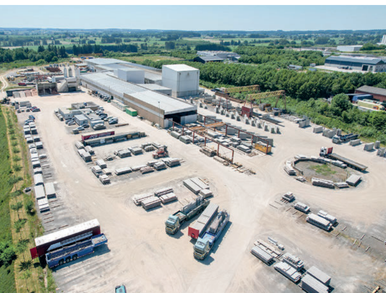
Alpha Beton lleva produciendo prefabricados de hormigón desde los años 90, al principio con mucha mano de obra y ahora de forma altamente automatizada.
