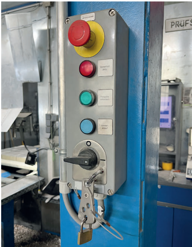
Sicher und praktikabel: Lockout-Tagout-Wartungssicherung
