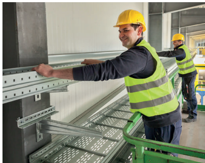
Professionell und termingerecht: Verlegung der neuen Kabel
