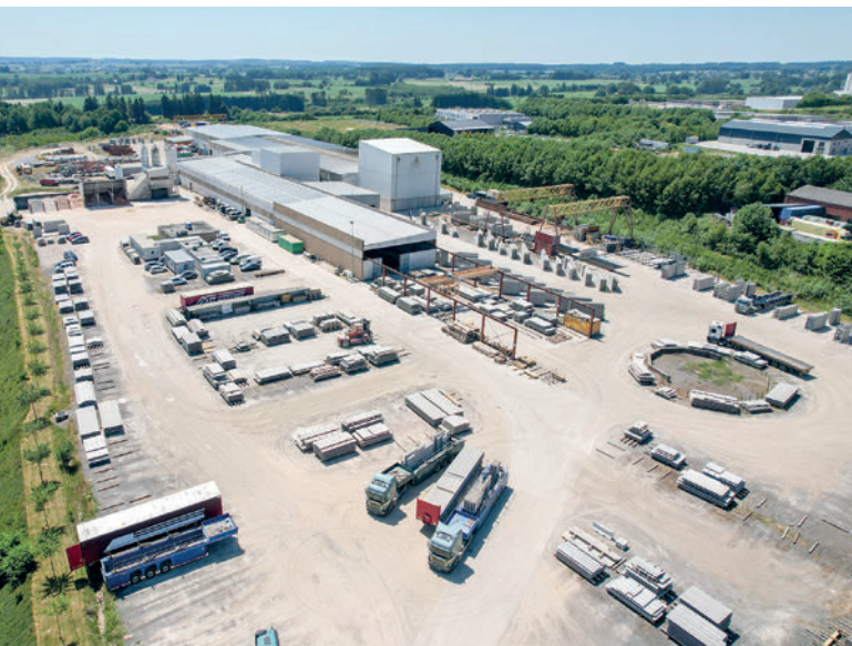
Alpha Beton produziert seit den 90er Jahren Betonfertigteile – zuerst mit viel Handarbeit und nun hochautomatisiert.
