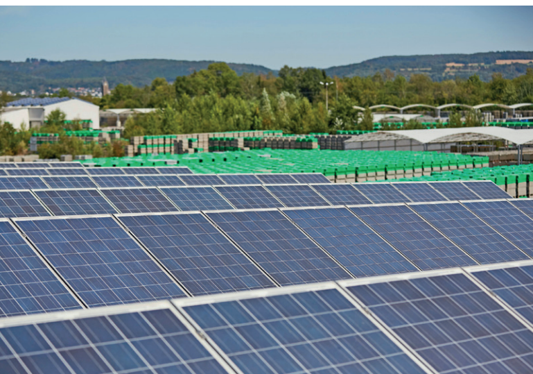
现代化且组织良好：德国 Urmitz 的 Rünz & Hoffend 混凝土工厂
