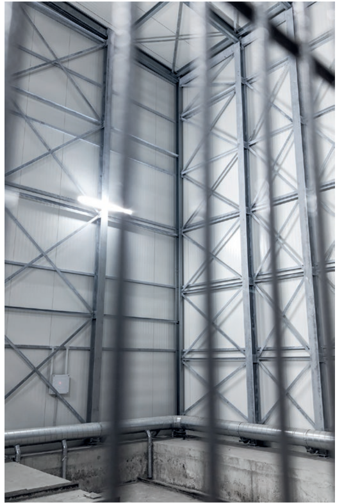
Dodatkowo zamontowano system dystrybucji gorącego powietrza w obszarze wózka wielowidłowego.
