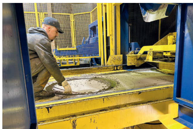
Inserimento dell'anello di rinforzo durante la produzione di un anello per pozzetto
