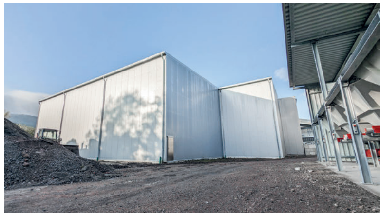
Chambre de cure conçue comme un bâtiment autonome avec une porte de secours en acier inox
