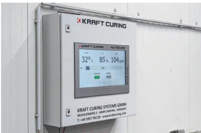
*Sistema de control de la cámara de curado con el software Autocure*
