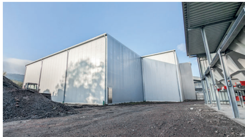
Härtekammer als freistehendes Gebäude und Fluchttür aus Edelstahl
