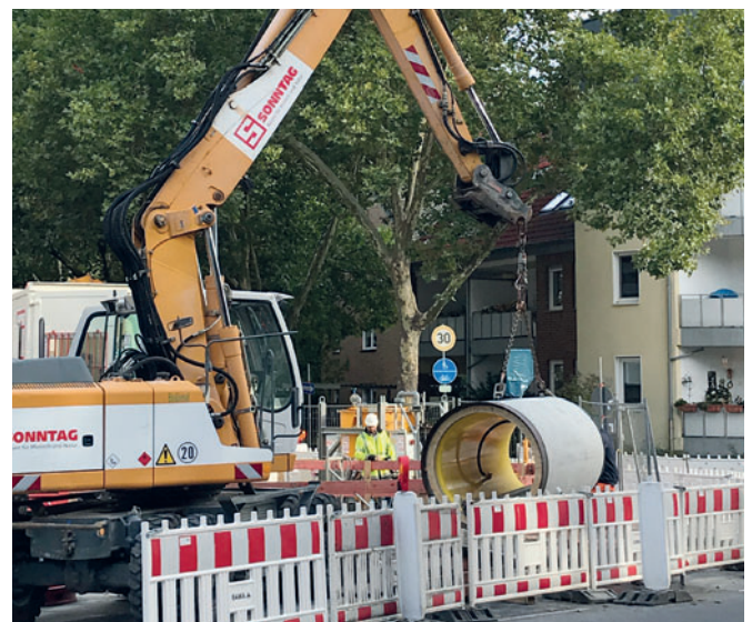
Проект Datteln: спуск в стартовый котлован, система для подачи бентонитовой смазки
