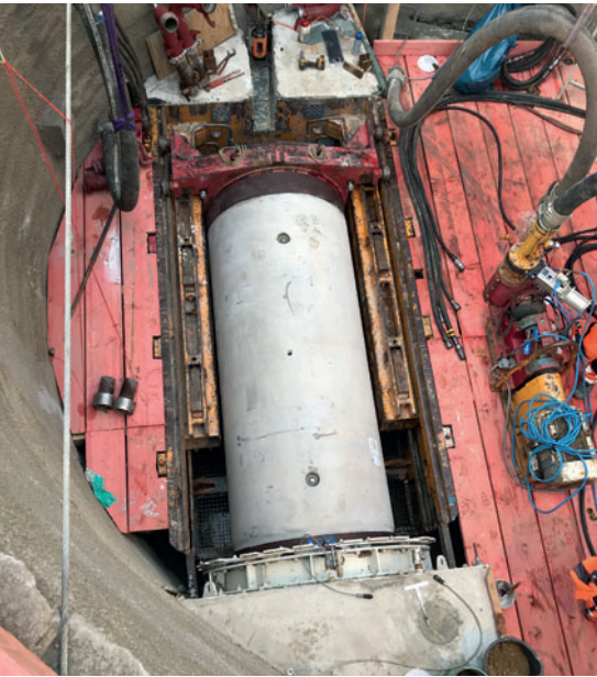
Проект Datteln: соединение с помощью коннектора уже выполнено до начала продавливания следующей трубы
