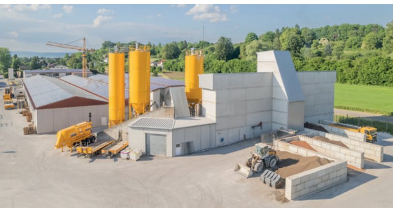
Бетоносмесительная установка с огороженными бункерами для заполнителей на заводе Fensterle
