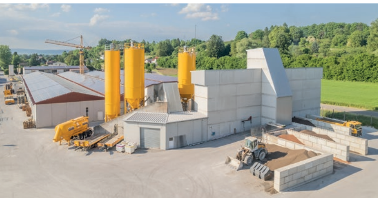
Widok na węzeł betoniarski z zabudowanymi komorami kruszywa w zakładzie Fensterle.
