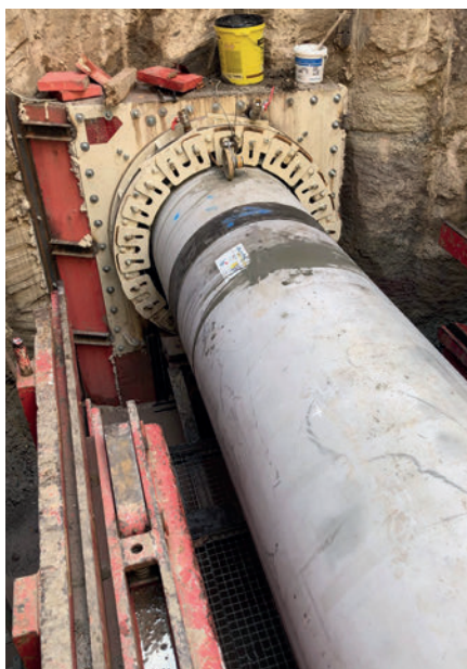
Progetto DN700, Medernach, Lussemburgo: scavo di ingresso
