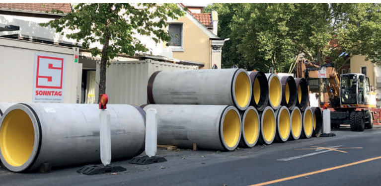
Progetto Datteln, Nordrhein-Westfalen, Germania: deposito di cantiere di Perfect Jacking Pipe DN1200 di Beton Müller.
