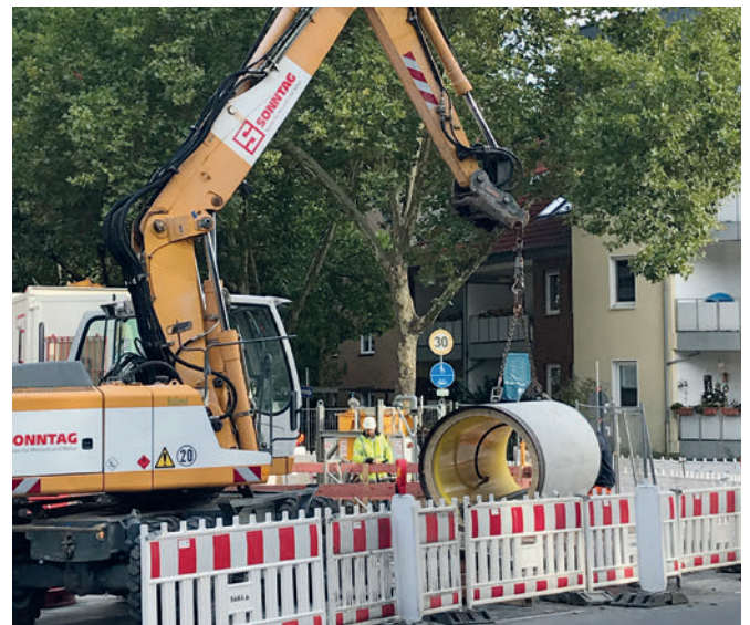
Progetto Datteln: sollevamento e posizionamento nello scavo di ingresso, dettaglio della tubazione di rivestimento con lubrificazione con bentonite.
