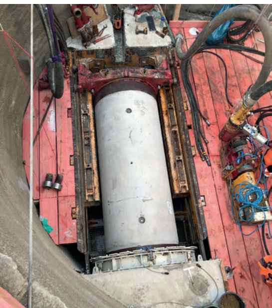
Progetto Datteln: il tubo successivo viene posato, la giunzione tramite connettore a innesto è già montata.
