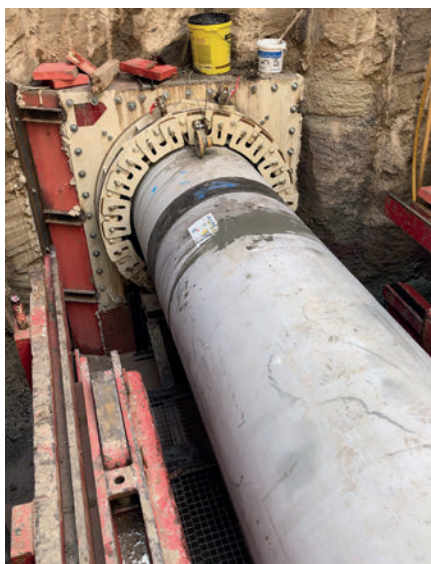
Chantier en diamètre 700, Medernach, Luxembourg : fosse de départ
