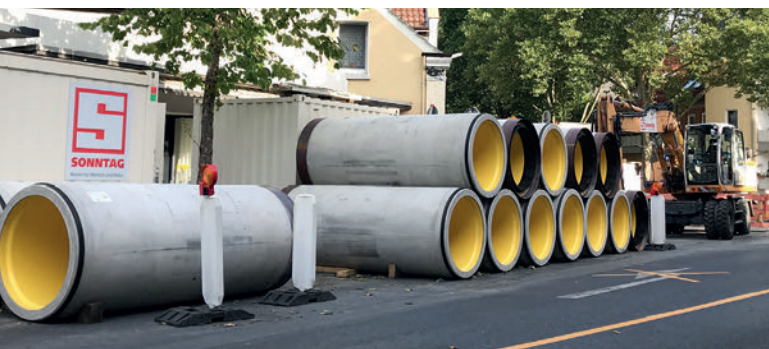
Chantier à Datteln, Rhénanie-du-Nord-Westphalie, Allemagne : entreposage de tuyaux de fonç age Perfect en diamètre 1200 livrés par Beton Müller
