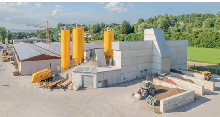
Vue sur la nouvelle centrale à béton avec ses trémies à agrégats logées dans un encoffrement, à l'usine de Fensterle
