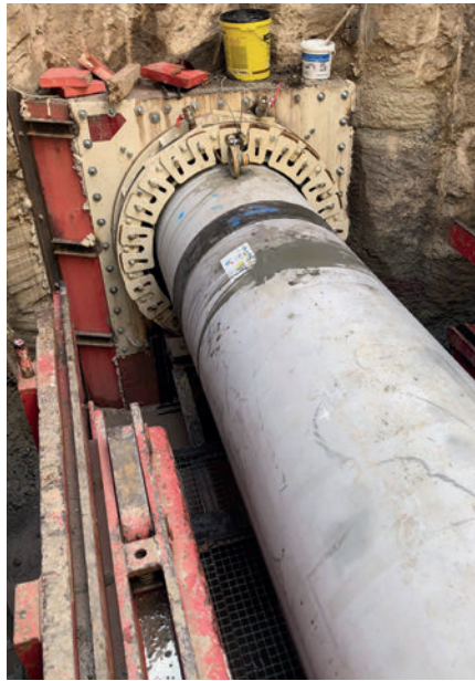
Proyecto DN 700, Medernach, Luxemburgo: zanja inicial
