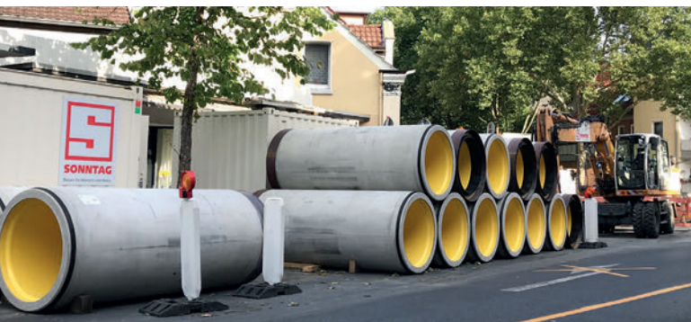
Proyecto Datteln, Renania del Norte-Westfalia, Alemania: almacén en obra de Perfect Jacking Pipe DN 1200 de Beton Müller.
