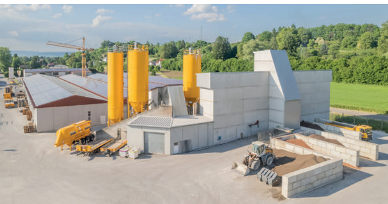
Vista de la planta de hormigón con los silos de áridos y su cerramiento en Fensterle
