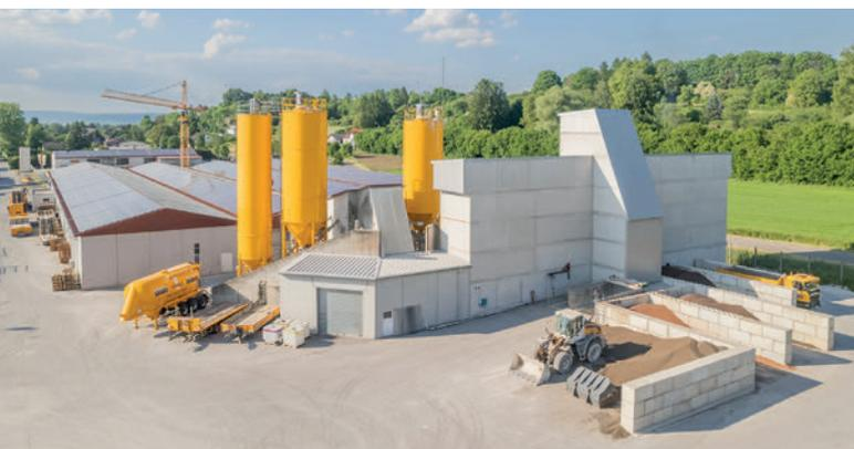
Blick auf die Betonmischanlage mit den eingehausten Gesteinskörnungssilos bei Fensterle
