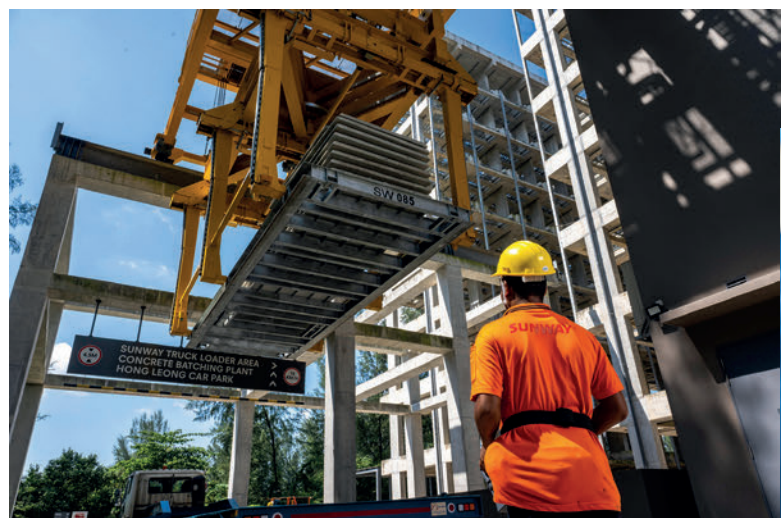
Der Palettenstapler garantiert ein sicheres Arbeitsumfeld und schnelles Handling der Paletten.
