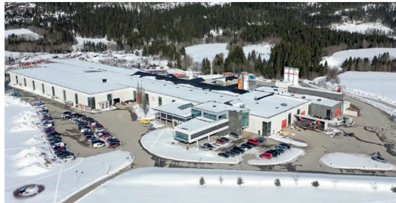
Das Fertigteilwerk in der Stadt Overhalla produziert seit den 1940er Jahren Baumaterialien.
