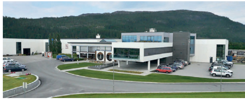
Overhalla Betongbygg ist Norwegens führendes Betonwerk in Sachen Automatisierung und Digitalisierung.
