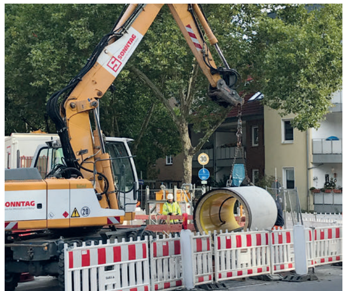
Projekt Datteln: Einheben Startgrube, Detail Verrohrung Bentonit-Schmierung
