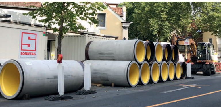
Projekt Datteln, Nordrhein-Westfalen, Deutschland: Baustellenlager Perfect Jacking Pipe DN1200 von Beton Müller
