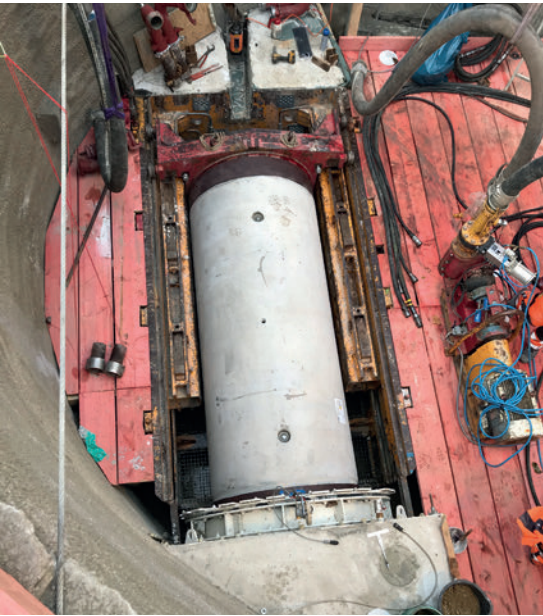
Projekt Datteln: Das nächste Rohr wird vorgepresst, die Fügung mittels Steckverbindung (Connector) ist bereits montiert.
