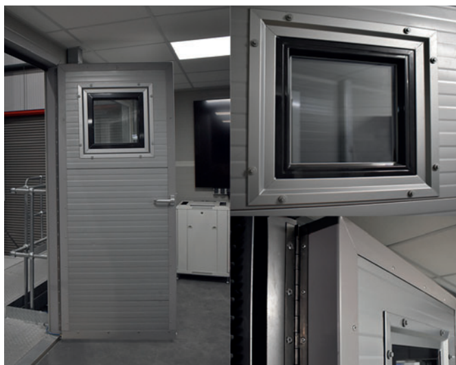
Двери для персонала из звукопоглощающего материала
