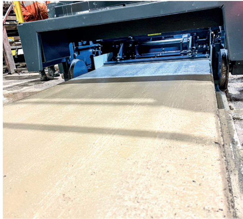
Бетон укладывается на стэнд, прессуется и остается за машиной для затвердевания
