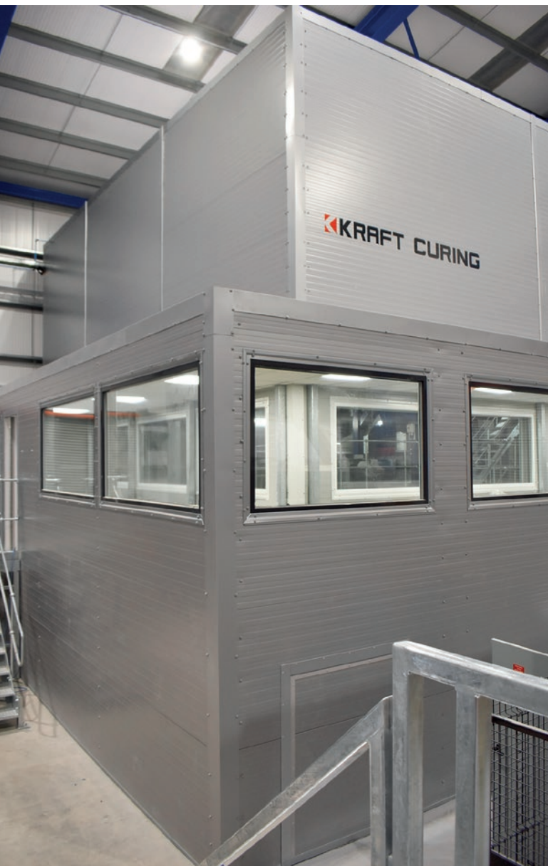
Zewnętrzna część pomieszczenia sterowniczego i maszynowni widoczna z fabryki.
