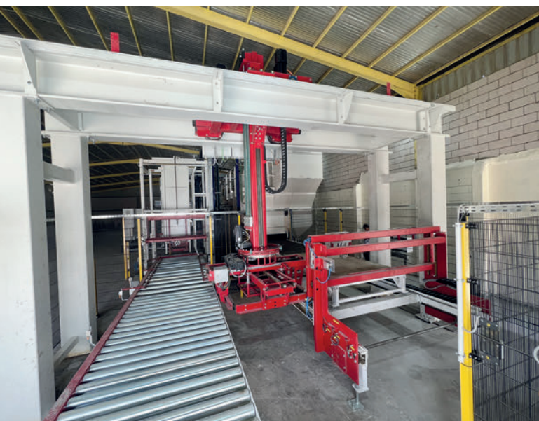
Caricamento dell'impilatore di strati
