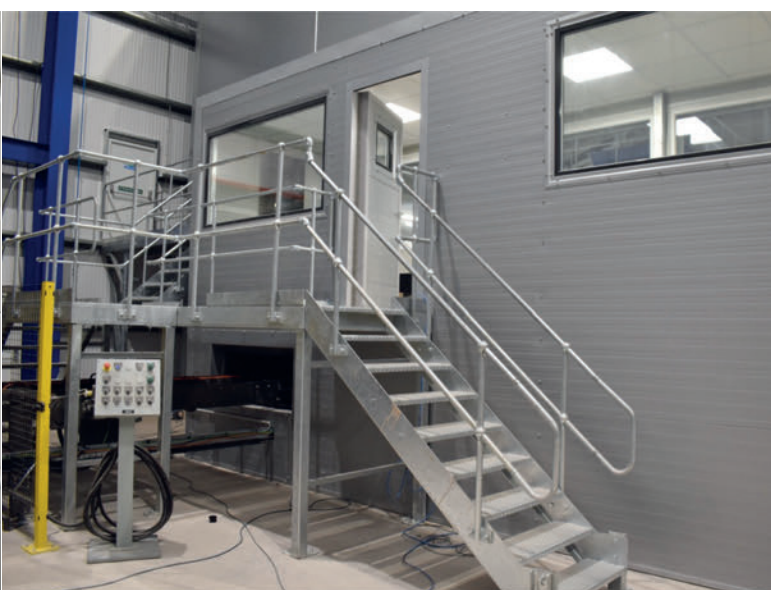
Soluzioni uniche che garantiscono la protezione contro il rumore e una buona visibilità nello stabilimento e nella sala macchine.
