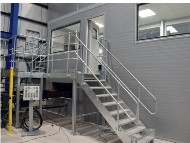
Un concept de vitrages unique permet de réduire les nuisances sonores, tout en offrant une bonne visibilité sur l'atelier et la salle des machines.
