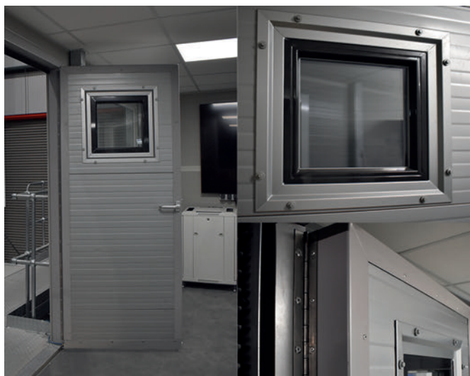
Détails des portes réalisées en matériaux d'absorption acoustique
