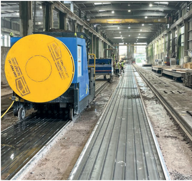
Les dalles en béton précontraint sont fabriquées sur des bancs de production de 1,2 m de large et 150 m de long.
